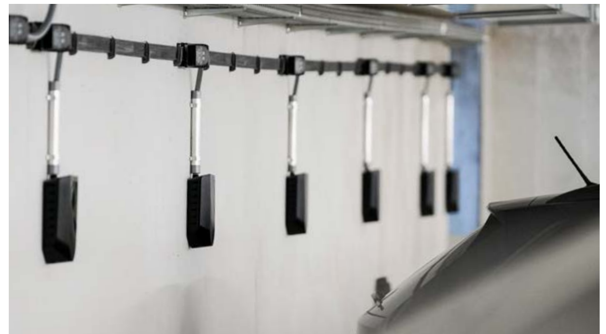
Voll eingestellt auf die Mobilität der Zukunft: Die Ladestationen können bei Bedarf beliebig erweitert werden.
