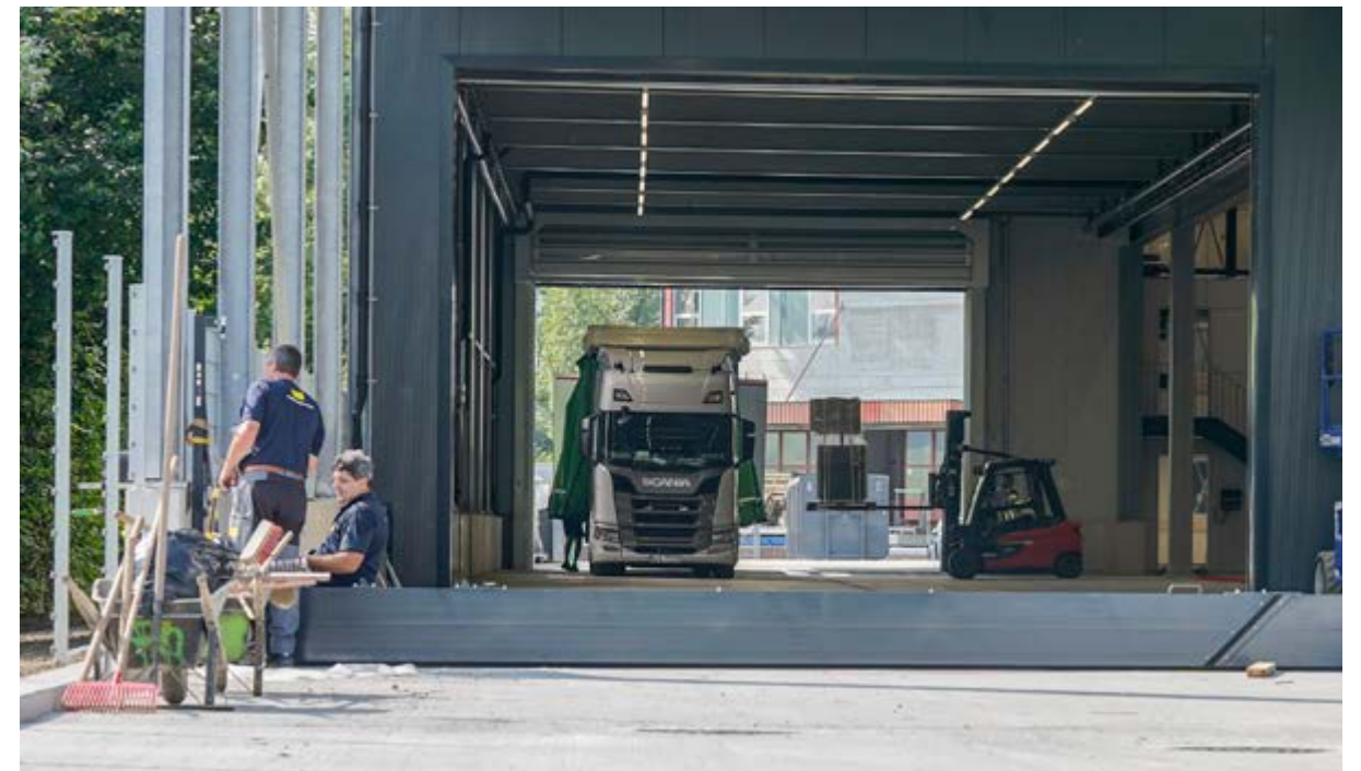
Millimetergenaue Montage: Einbau einer halbautomatischen Löschwasserbarriere – optimal angepasst an die baulichen Gegebenheiten.
