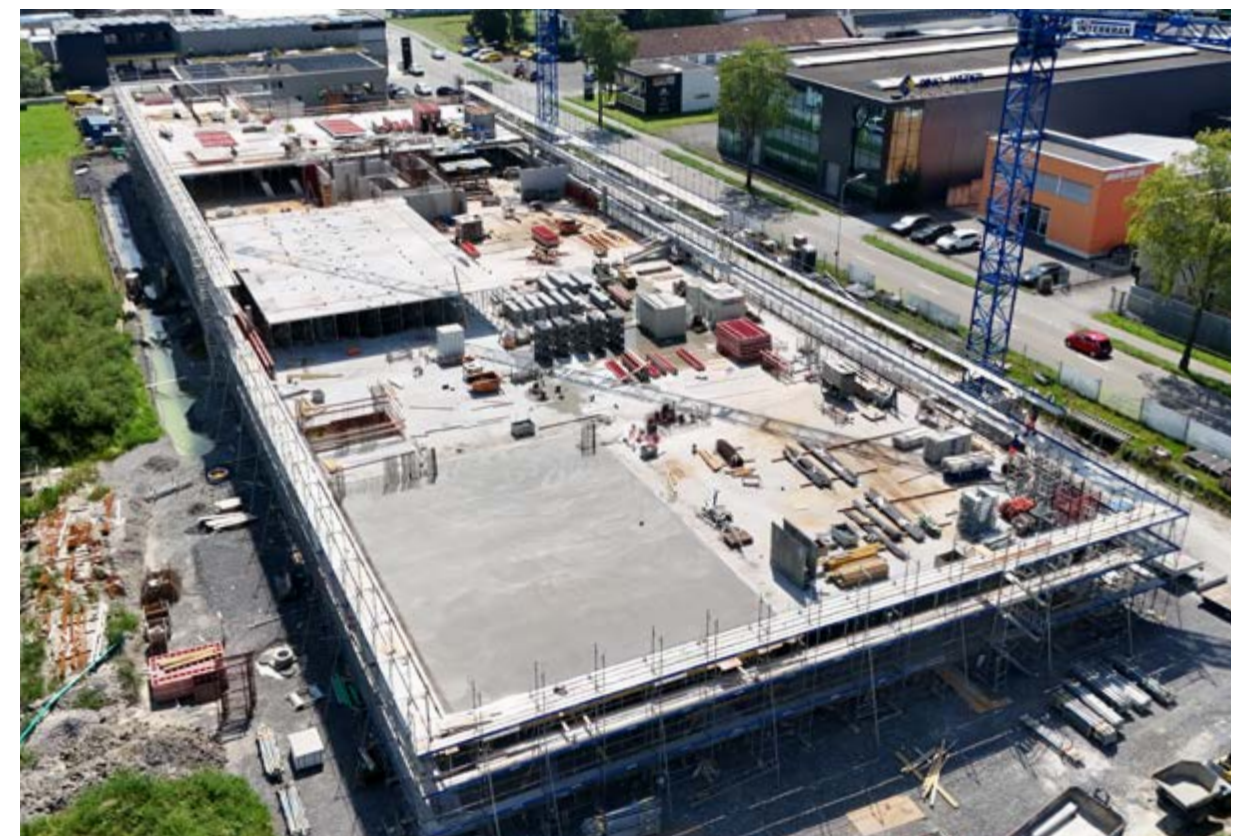
Aktueller Stand der Bauarbeiten am «park unique», festgehalten am 12.08.2025
