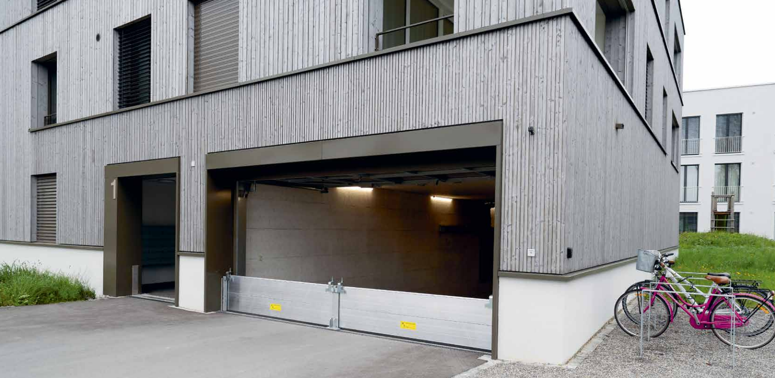
Systèmes de protection contre les inondations
