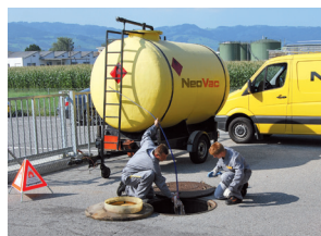
Revisione di serbatoi
