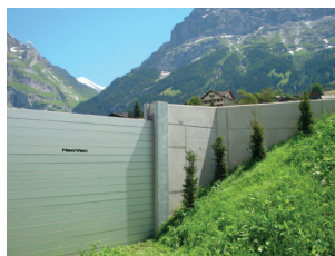
Systèmes de protection contre les inondations
