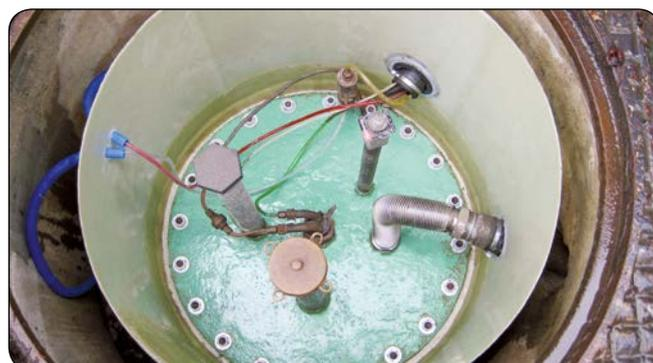
Der verschlossene Tank mit dem sanierten Domschacht
