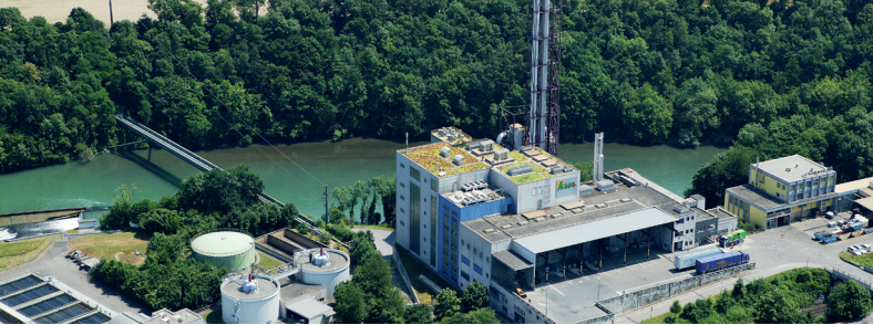
Il termovalorizzatore di Turgi: a destra del camino alto i due camini della caldaia di emergenza.
