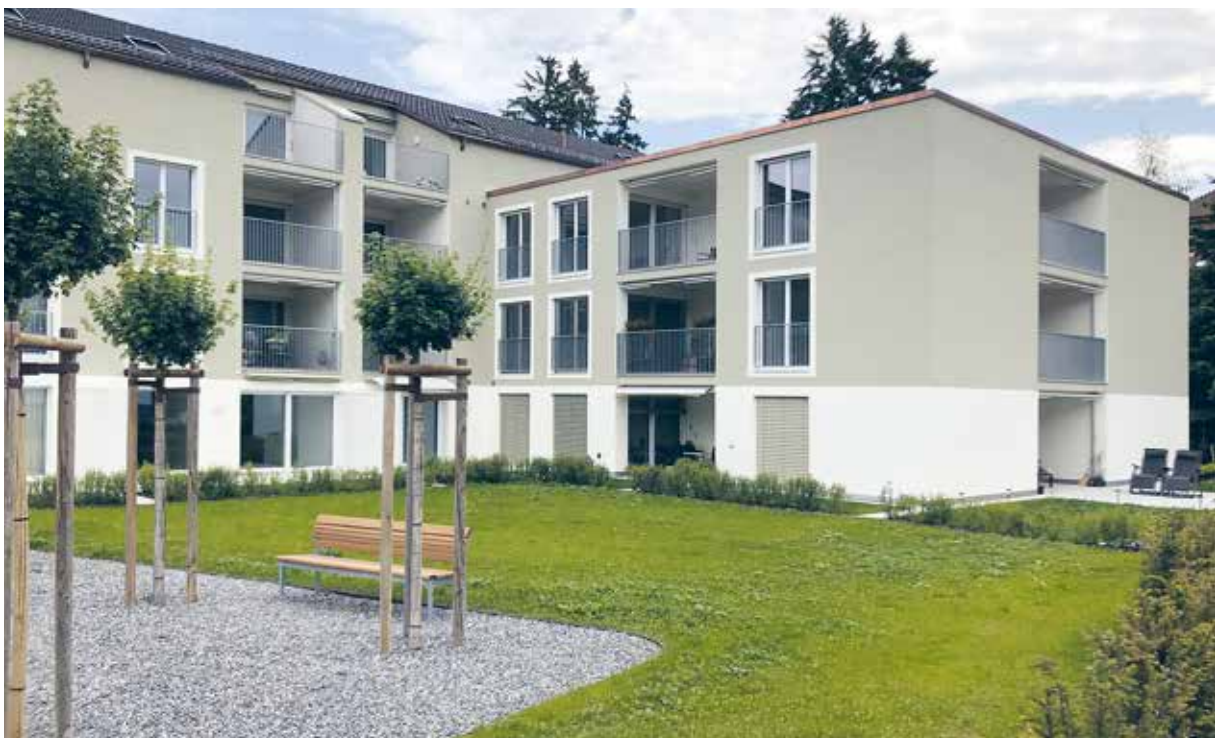
Das Minergie-Monitoring beim neuen Mehrfamilienhaus in Reinach (AG) zeigte, dass Fehleinstellungen aus der Inbetriebnahme optimiert werden mussten. (Foto: Jabez AG)
