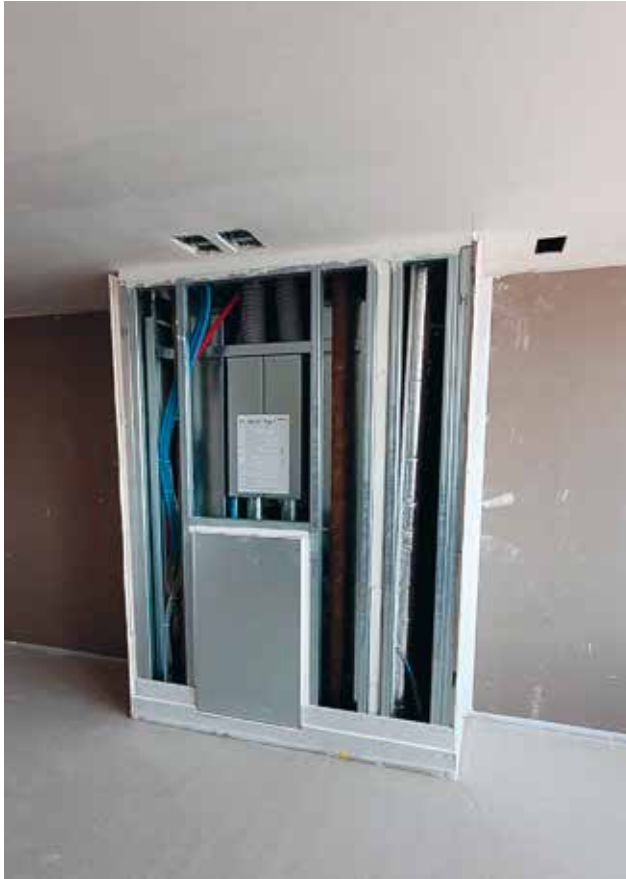
Die vorfabrizierten Gebäudetechnik-Module ermöglichen deutlich verkürzte Montagezeiten vor Ort.
