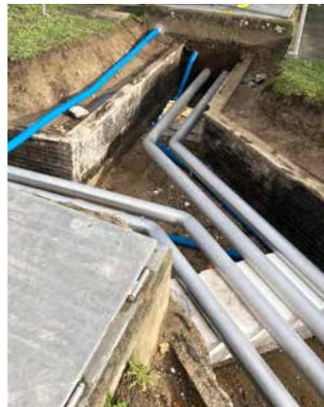
Insgesamt wurden 230 Meter doppelwandige Chromstahlleitungen verlegt.
