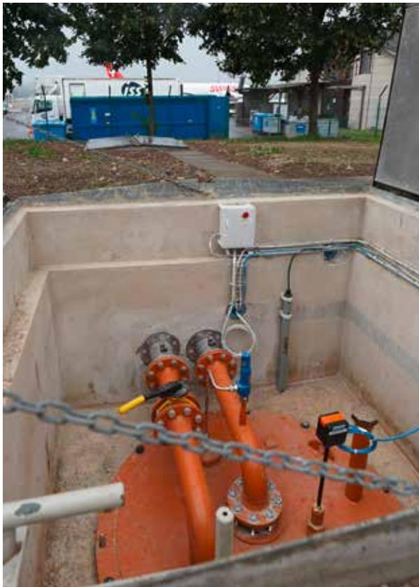
Der Armaturenschacht mit verschiedenen Überwachungssonden.
