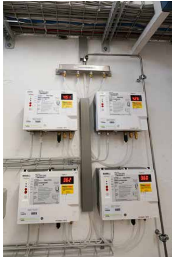
I dispositivi di monitoraggio per i tubi a doppia parete in acciaio al cromo.
