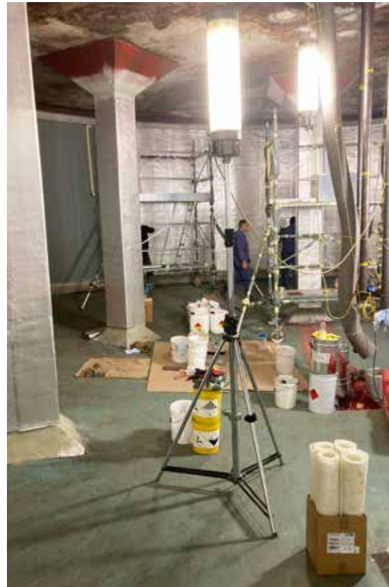
I lavori del progetto sono durati complessivamente cinque mesi.
