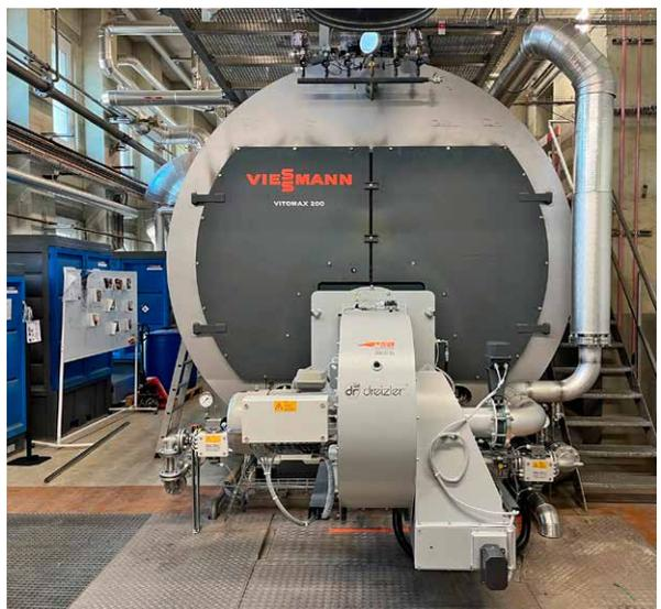
Der Dampfkessel 8 t/h mit Zweistoffbrenner Öl/Gas inklusive automatischer Mischfeuerung Biogas auf beiden Brennstoffen (14 bar Dampfdruck).
