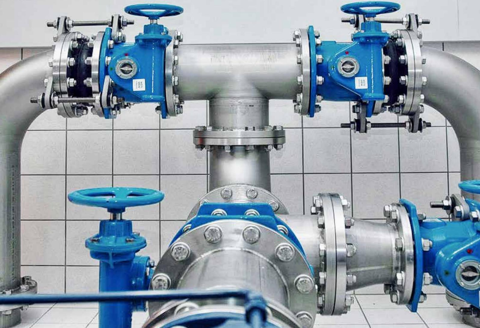
Zulauf mit Einführung in zwei Wasserkammern ↑      Entnahmeleitung mit Reserveanschluss ↓
