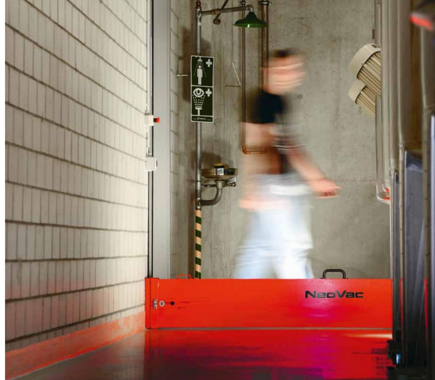
**Vous recherchez des systèmes de protection robustes pour empêcher la pénétration d'eau d'extinction contaminée ? Les barrières de retenue d'eau d'extinction d'incendie NeoVac isolent parfaitement les entrées et les sorties et rendent l'environnement plus sûr.**
